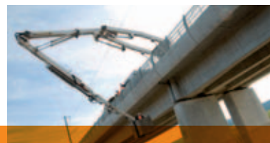
Inspection de contrôle d'un pont-rail avec nacelle ferroviaire Ougney [39]
