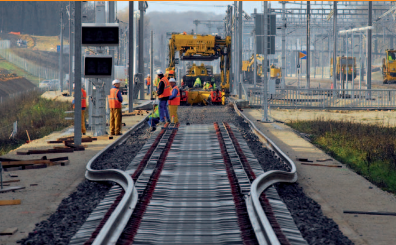
Pose de voie gare de Besançon Franche-Comté TGV Auxon-Dessus (25)
