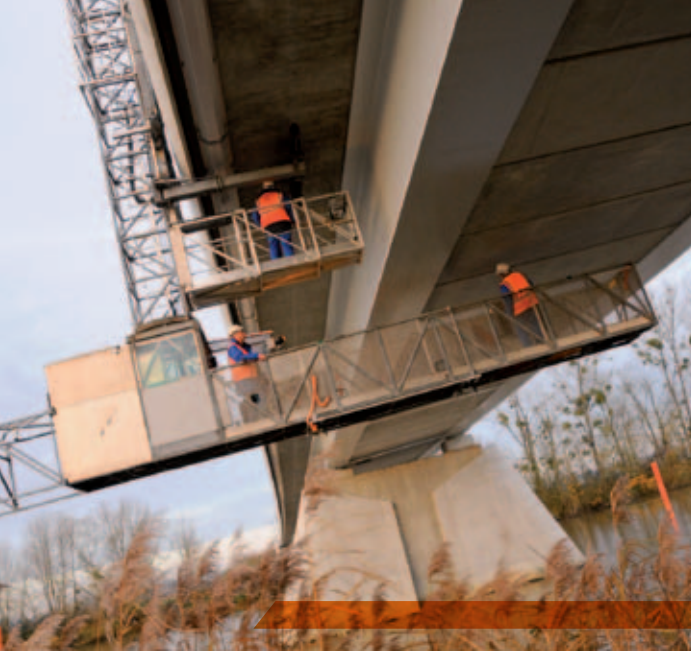
Inspection de l'ouvrage par nacelle « MOOG », viaduc de la Saône (21)
