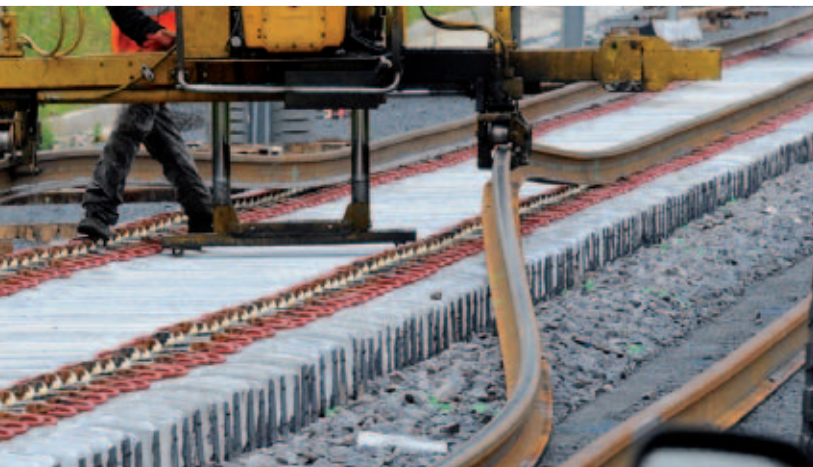
Chavanne (70) Installation des longs rails soudés.
