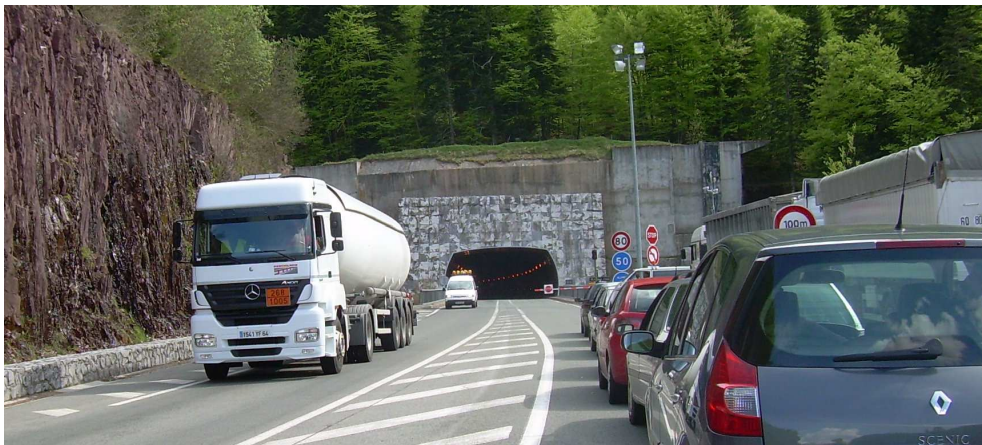
Tunnel du Somport (bouche côté France, sortie d'un convoi MD ayant nécessité l'arrêt des VL)
